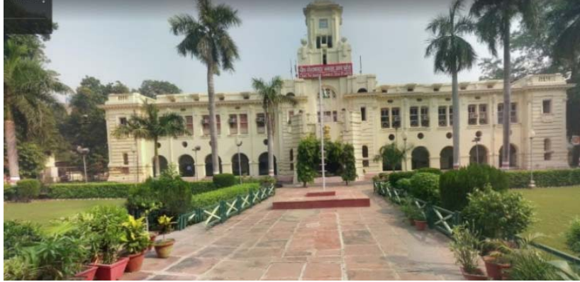
प्लेट 3 – स्मारक की पूर्वोत्तर दिशा में मुख्य पोस्ट मास्टर जनरल का कार्यालय Plate 3, Chief Post Master General Office in north-east direction of the monument
