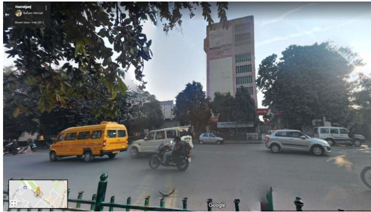
प्लेट 12 - स्मारक के उत्तरी ओर हजरतगंज का दृश्य Plate 12, View of Hazratganj. in north direction of monument
